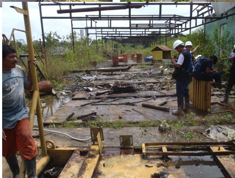
Les moniteurs de Feconat documentent des sols et des eaux pollués aux hydrocarbures et des installations pétrolières abandonnées au milieu de la forêt
